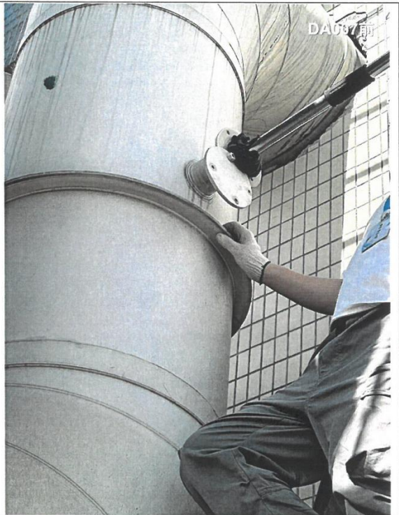
图 9.10 破碎废气处理前检测口 ◎Q4
