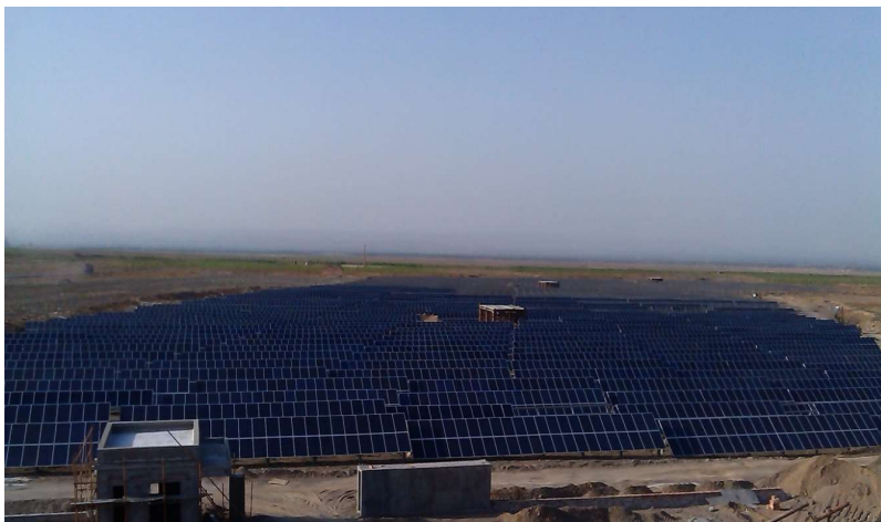
阿克塞县陆泰200兆瓦光伏发电项目
