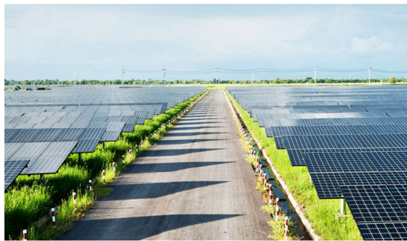
西藏沛德堆龙德庆30兆瓦牧光互补复合并网发电项目
