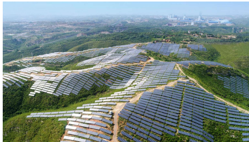
江苏省泗洪县峰山240MW项目
