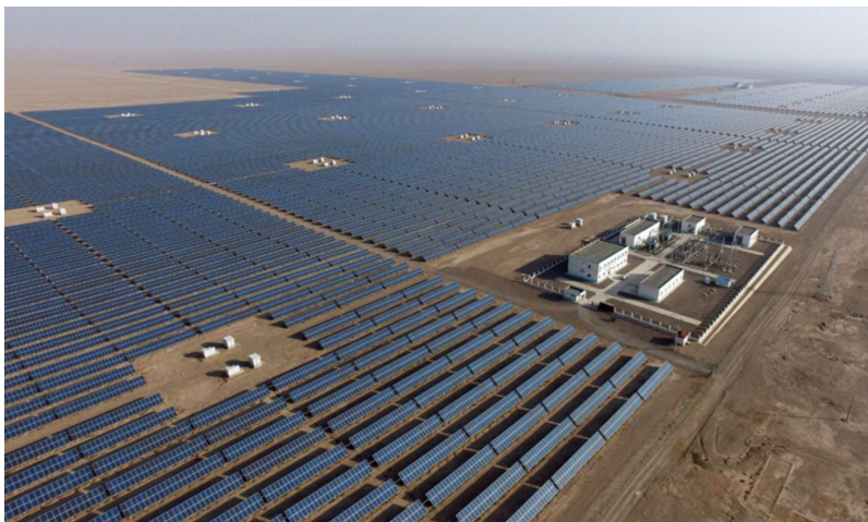
武威市凉州区杭泰200MW光伏发电项目
